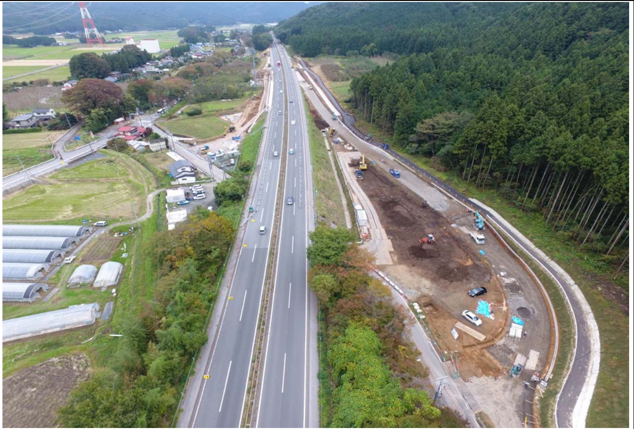
平成30(2018)年10月23日時点 : 擁壁や大型水路が完成し、盛土工事が進んでいます。
