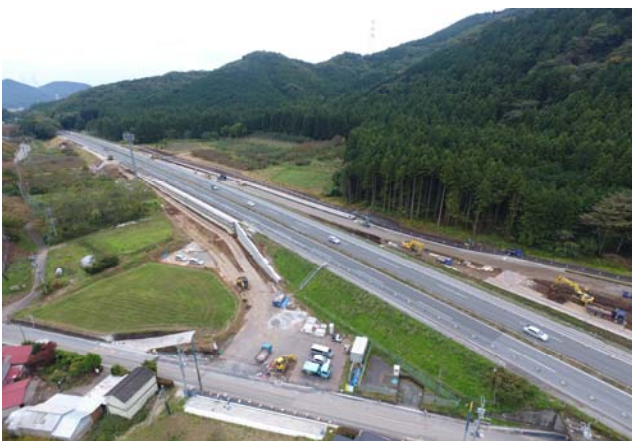
平成30(2018)年10月23日時点 : 擁壁や大型水路が完成し、盛土工事が進んでいます。
