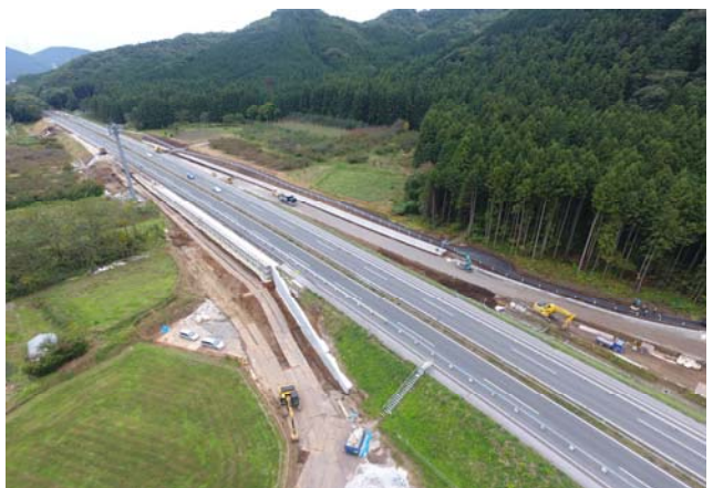
平成30(2018)年10月23日時点 : 擁壁や大型水路が完成し、盛土工事が進んでいます。
